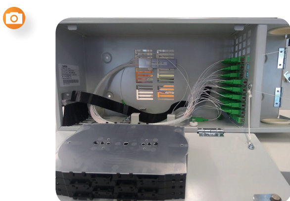
Os conectores SC/APC podem ser utilizados em todos os registos (principais, secundarios e PAUs)
